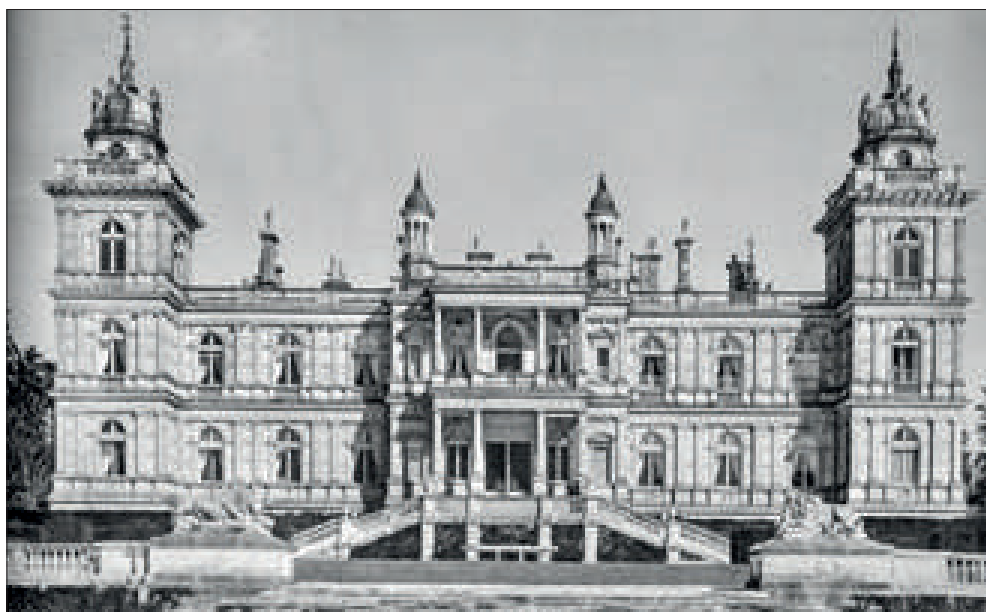
Façade sur jardin du château de Ferrières (Ferrières-en-Brie, Seine-et-Marne)
