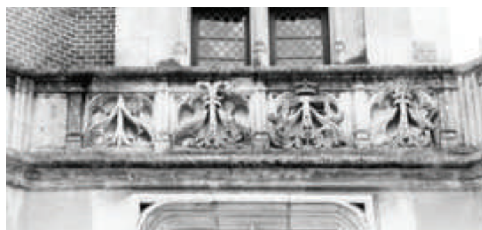
Fig. 2 - Élément du garde-corps du pavillon Anne de Bretagne, calcaire. Val-de-Loire, début du XVI e siècle. Château de Blois, facade ouest.
