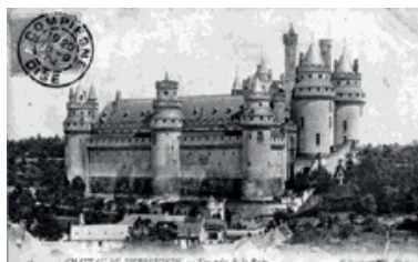
fig. 1 : Le Château de Pierrefonds à l'orée de la forêt de Compiègne, vue prise de la Roche, état en 1920
